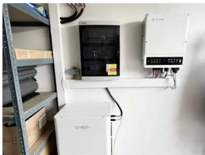
Aangesloten op omvormer en meterkast
